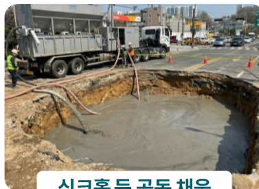
싱크홀 등 공동 채움
